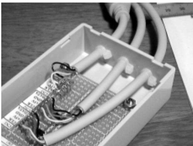
写真10 結束具でケーブルを固定している所
